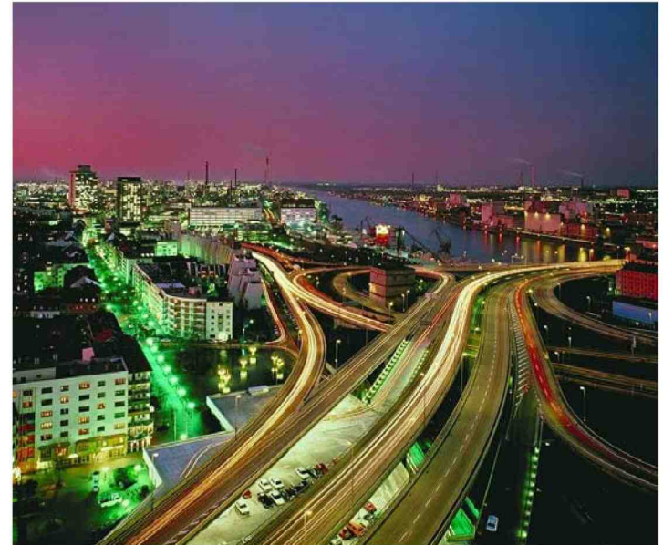
Hochstraßen nördlich des Zollhofhafens
