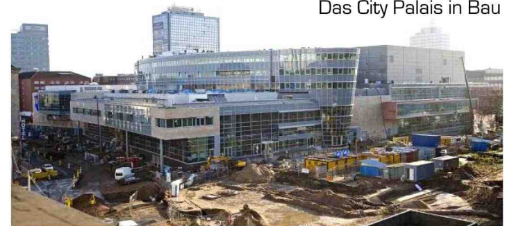
Das City Palais in Bau
