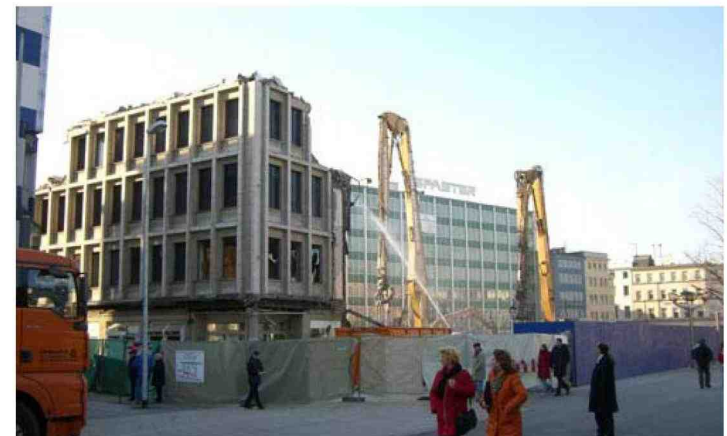
Abriß des alten Karstadt - Hier entsteht das neue Forum Duisburg
